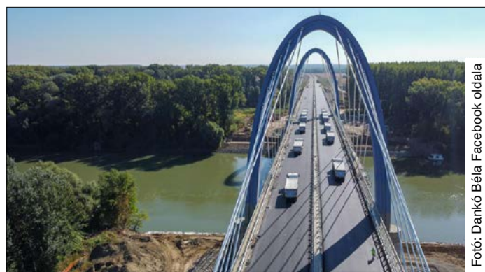
Lezajlott az M44-es Tisza-hídjának a próbaterhelése
