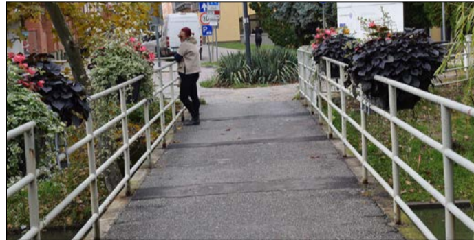
A Deák utcai híd felújítása tavasszal kezdődik
