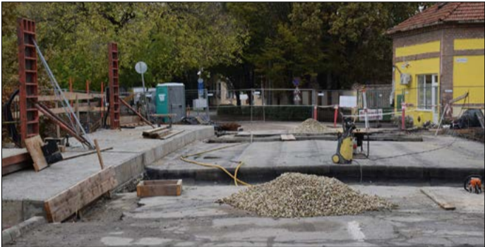
Jól halad a Kórház és Kiss Ernő utcai híd építése
