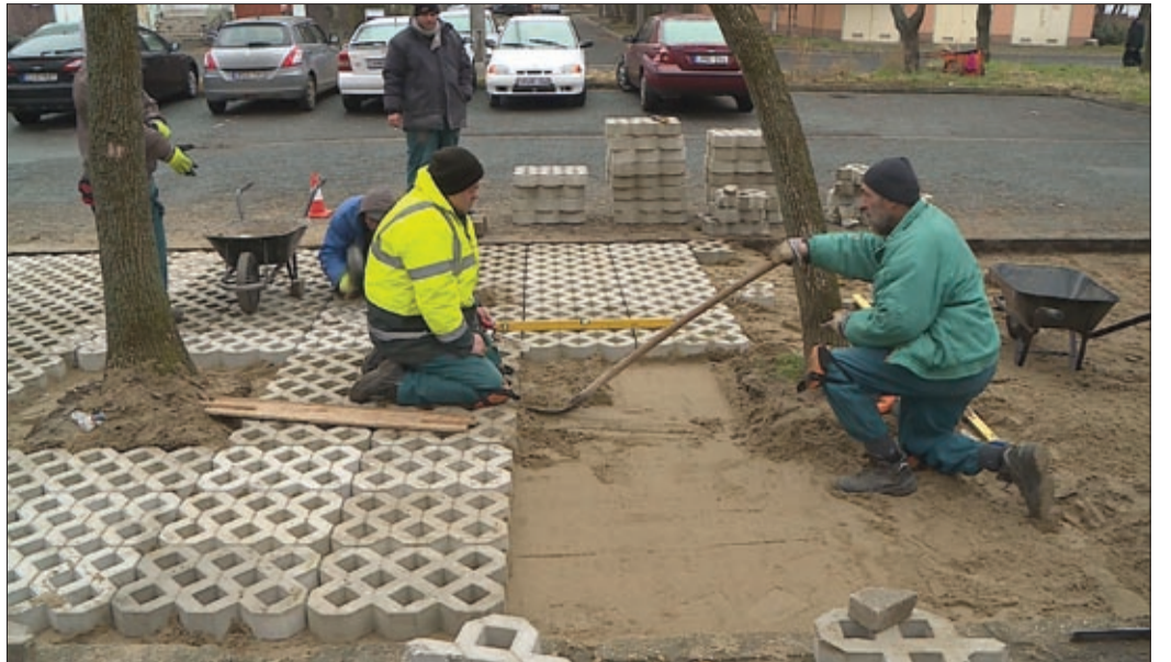
A közfoglalkoztatottak készítették a térköveket, amelyekből a burkolat épül
