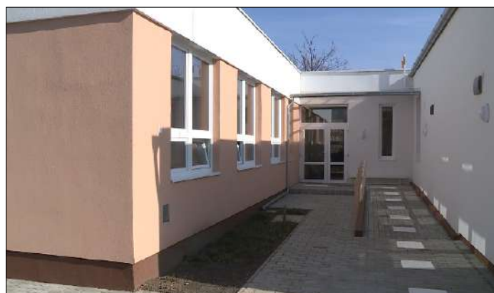
A Tündérkert Óvoda teljes energetikai felújítást kapott
